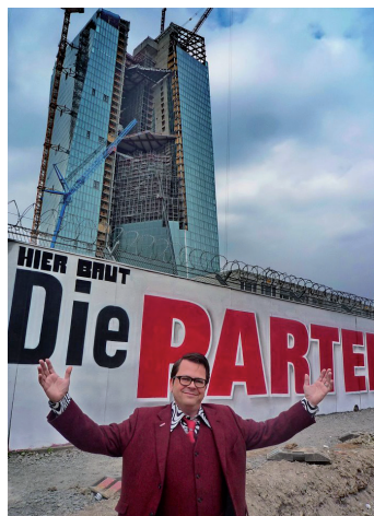
EZB (Erster Zentraler Bau der PARTEI) -Baustelle, April 2013
